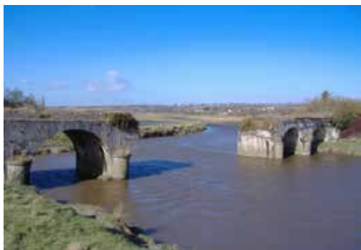
Le Pont de la Roque à Heugueville-sur-Sienne
